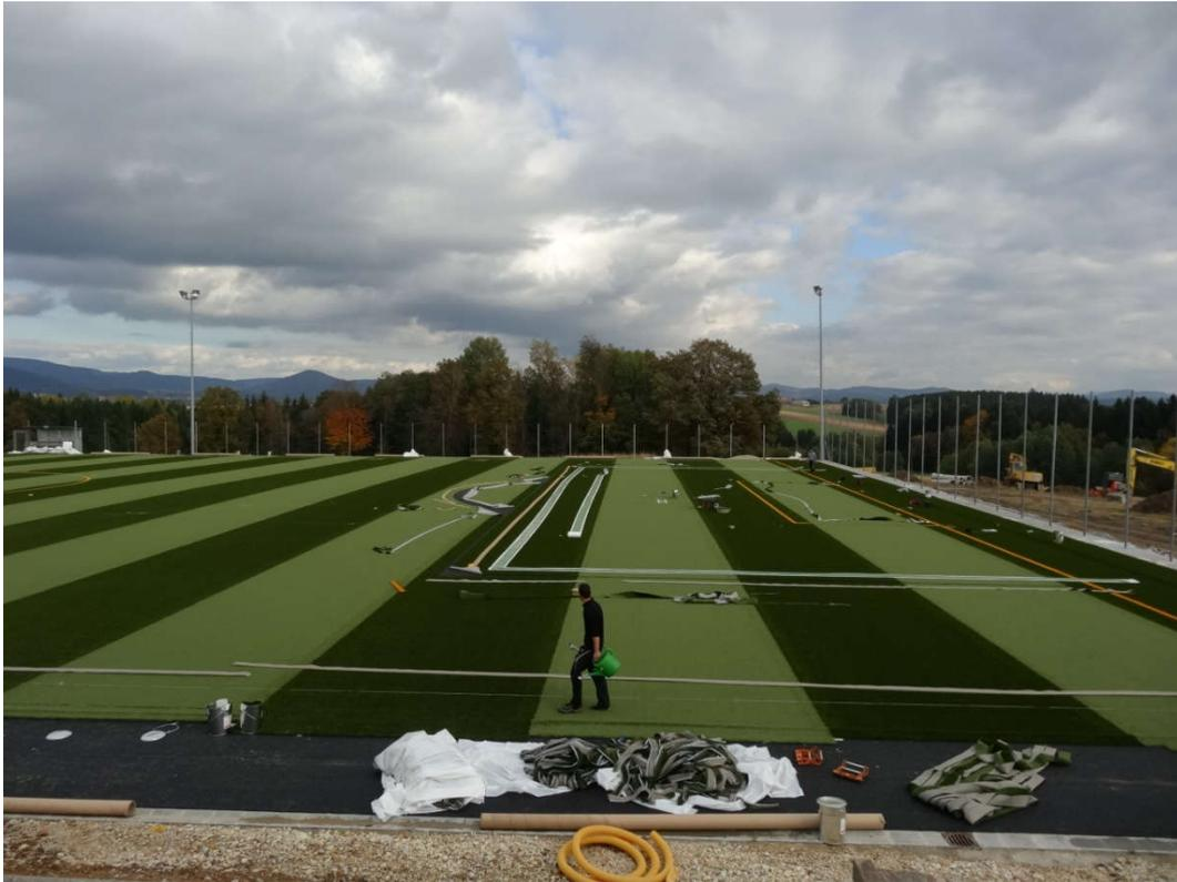
Die Linien aufgemalt und dann kommt das Granulat und die Grasspitzen werden mit einer Maschine aufgestellt und sieht dann so aus.
